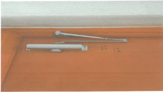
3층 원형계단쪽 도어클로저 교체
