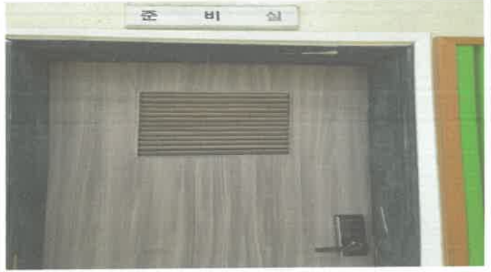
대체육관 준비실 도어락 설치
