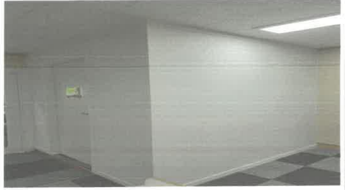
1층 온라운지 내 독서실 창고 도색
