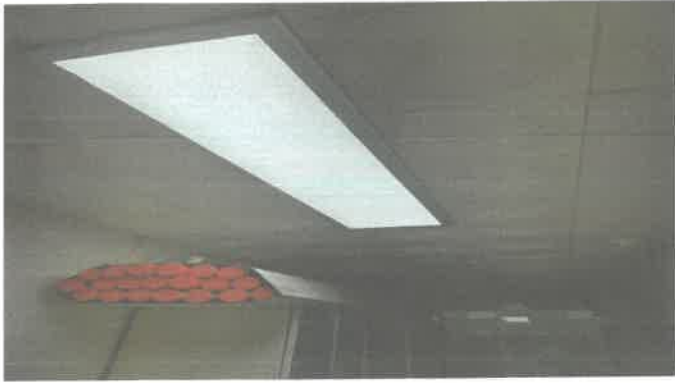
수영장 남자탈의실 앞 통로 전등교체
