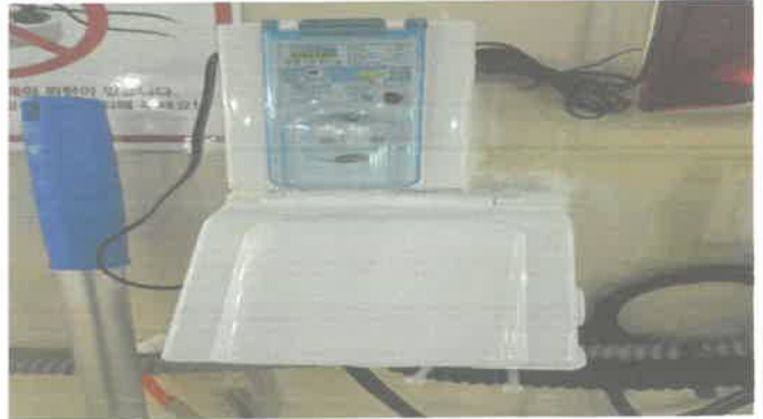
수영장 내 양호실 앞 방우형 콘센트 설치
