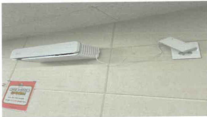
온라인지 스튜디오 벽면 콘센트 설치
