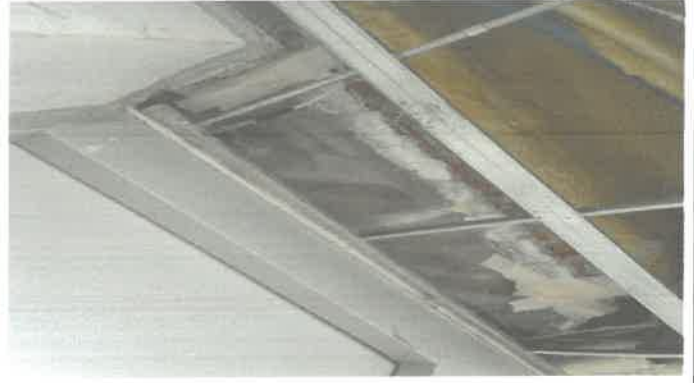
기사대기실 천장 집수비닐망 설치
