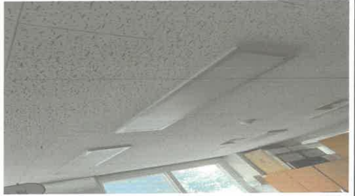
생활체육팀 천장 전등2개소 설치
