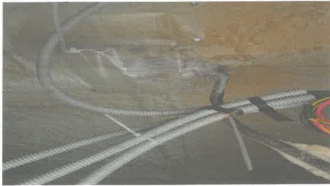
기사대기실 옆 천장 집수비닐망 설치
